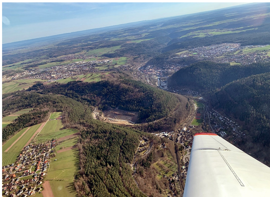
Im Luftbild liegt links unten Ottenbronn, rechts unten Hirsau, dahinter nach Süden das Stadtzentrum von Calw und links oben Heumaden sowie Kimmich. Die Mitte zeigt die ansteigende Kehrschleife der Bahntrasse um den Welzberg ins Tälbachtal/Fuchsklinge mit dem Tunneleingang.
